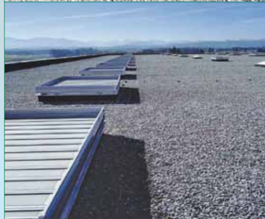
Dach balastowy obciążony żwirem
