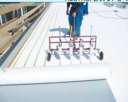
Nakładanie warstwy klejącej na dachu
