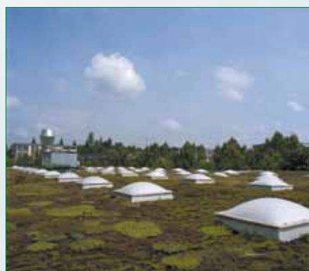
Dach pokryty trawą w systemie AUSTROPLAN FPO.
