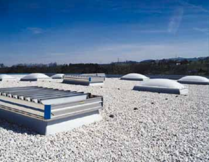
Dach obciążony żwirem z zastosowaniem systemu membran AUSTROPLAN FPO
