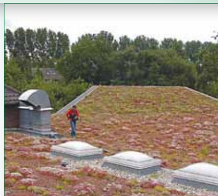
Dach pokryty trawą w systemie AUSTROPLAN FPO.
