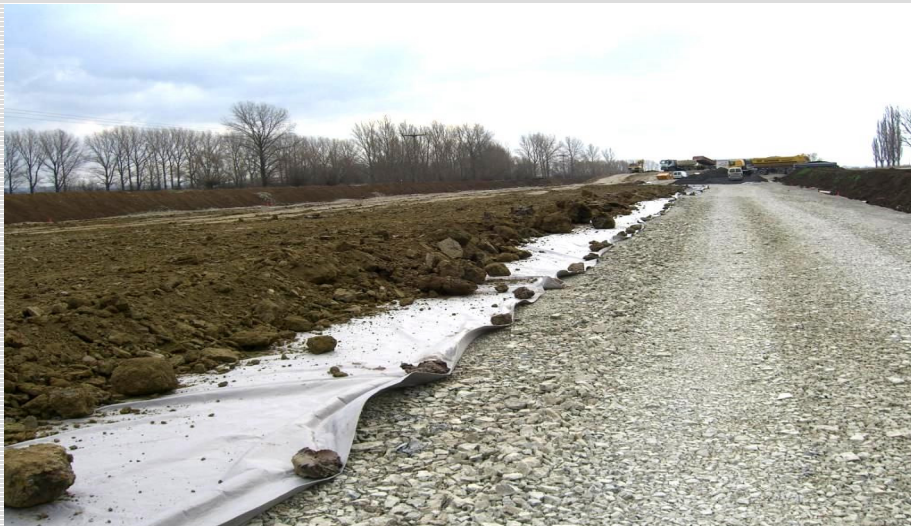
Abb. 4: Weitere Aufschüttung des Straßendamms
