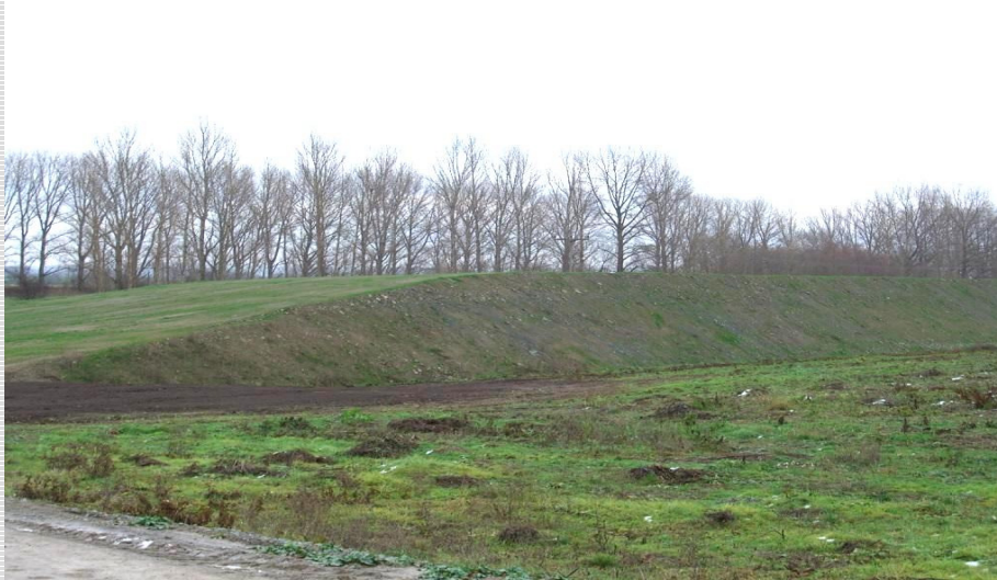
Abb. 7: Endzustand des begrünerten Damms
