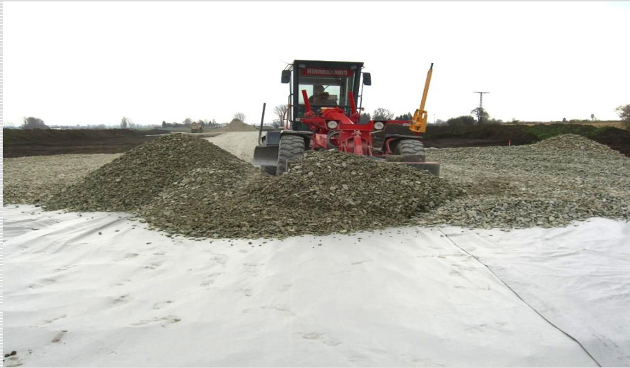
Abb. 3: Überschüttung mit Schotter und Vorkopfeinbau
