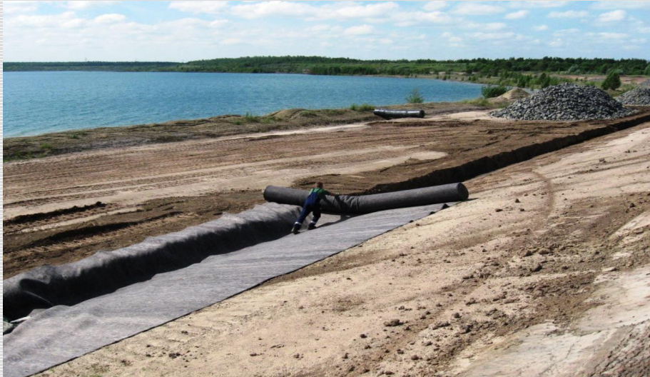
Abb. 1: Verlegung des Wasserbauvlies
