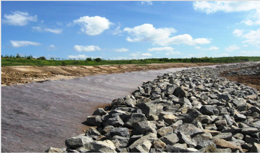
Abb. 3: Teilweise Überschüttung mit Wasserbausteinen
