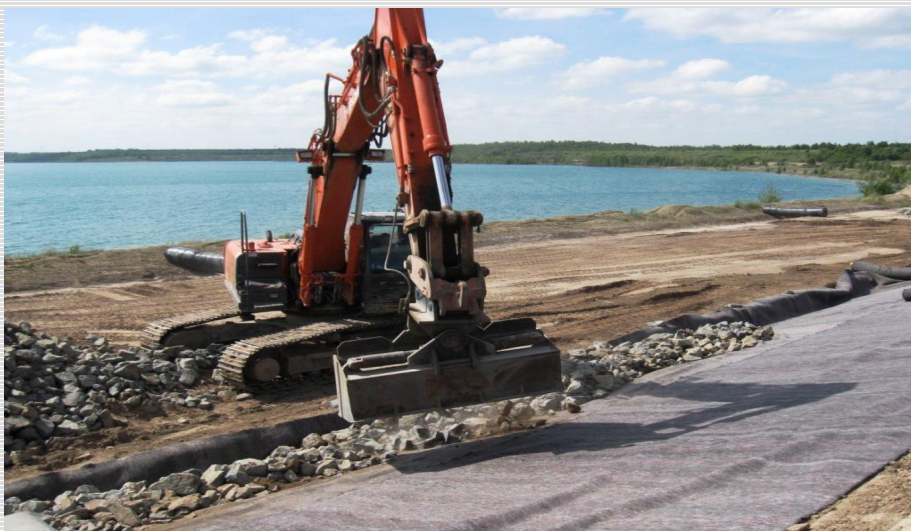
Abb. 2: Überschüttung auf verlegtes Wasserbauvlies
