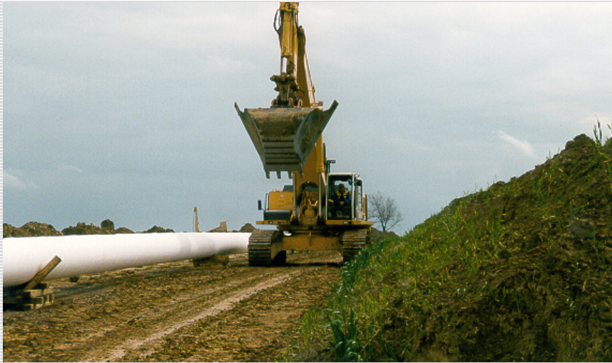
Abb. 3: Gasrohr mit ummanteltem Rohrschutzvlies
