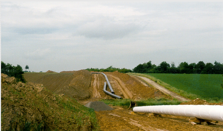
Abb. 2: Gasrohr mit ummanteltem Rohrschutzvlies
