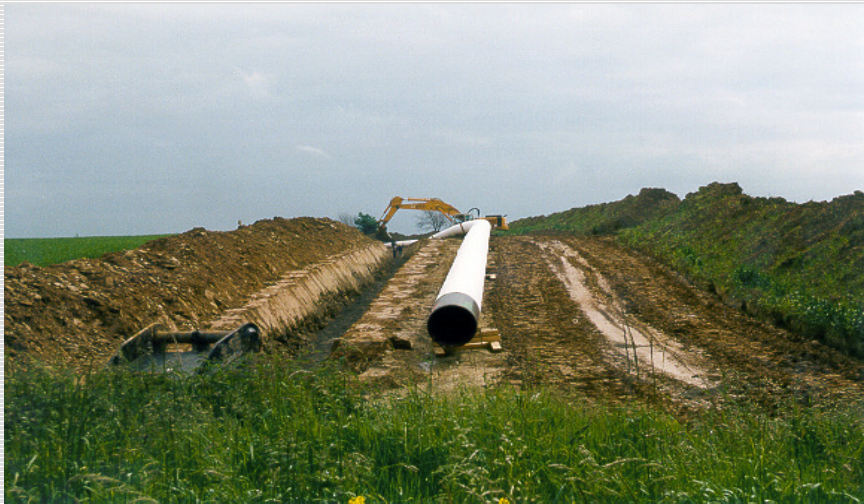
Abb. 1: Gasrohr mit ummanteltem Rohrschutzvlies
