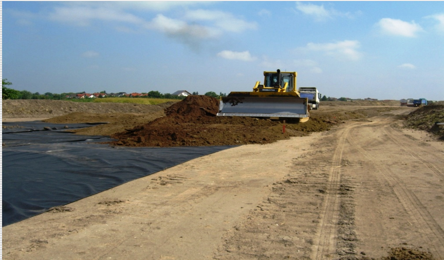
Abb. 3: Vorkopfüberschüttung
