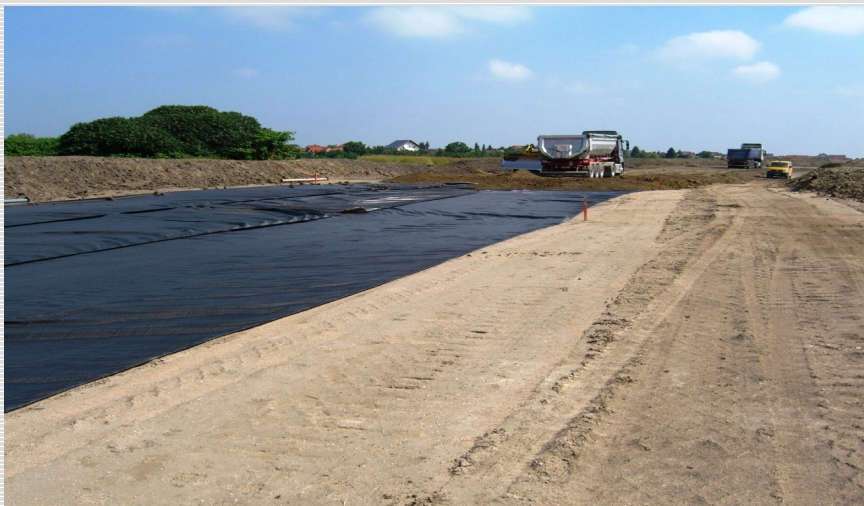
Abb. 2: Verlegtes Bändchengewebe
