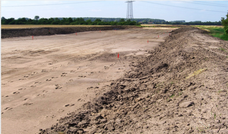
Abb. 1: Baufeld vor Verlegung
