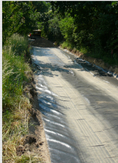
Abb. 1: Ausgelegtes Gewebe vor Überschüttung
