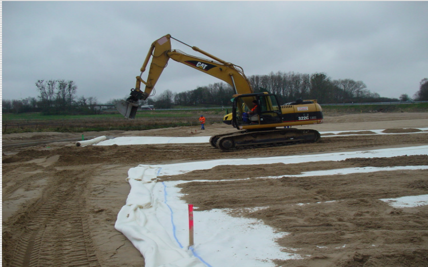
Abb. 3: Aufbringen der 1. Lage über dem Gewebe
