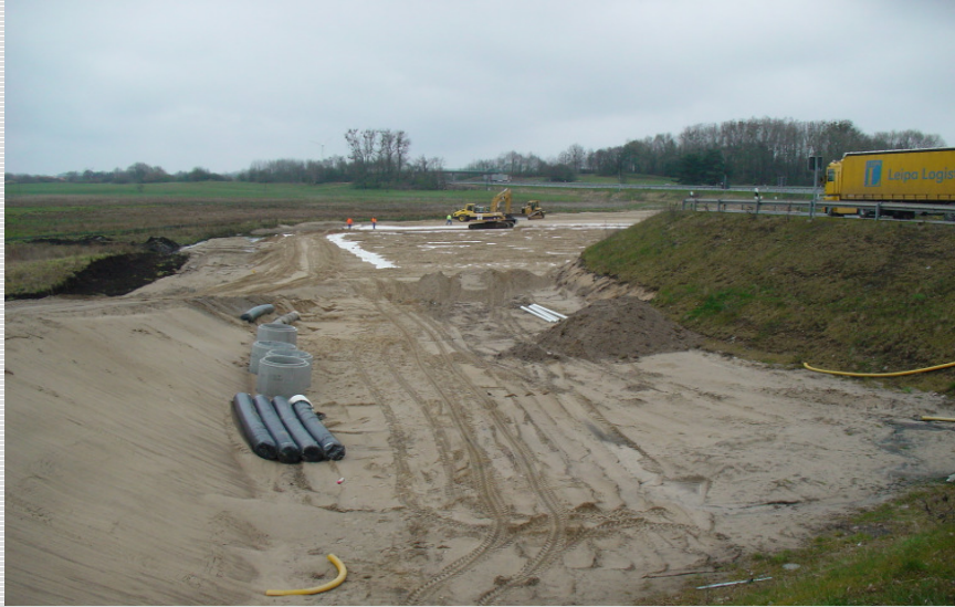
Abb. 1: Ansicht der Baustelle
