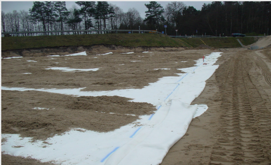
Abb. 2: Verlegung quer zur Straßenachse
