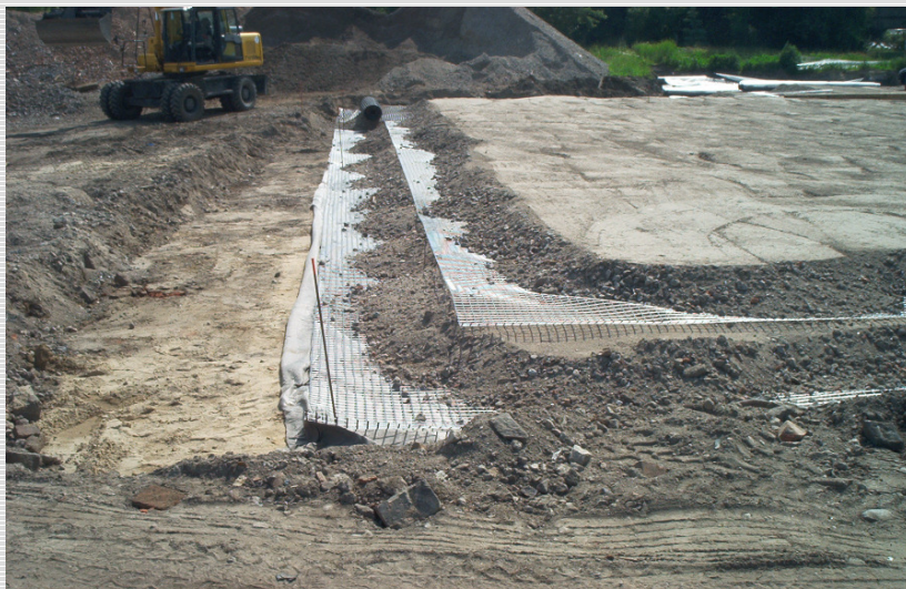
Abb. 2: Verlegung von Gitter und Vlies in zwei getrennten Lagen
