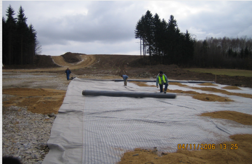
Abb. 3: Verlegung des Gitters
