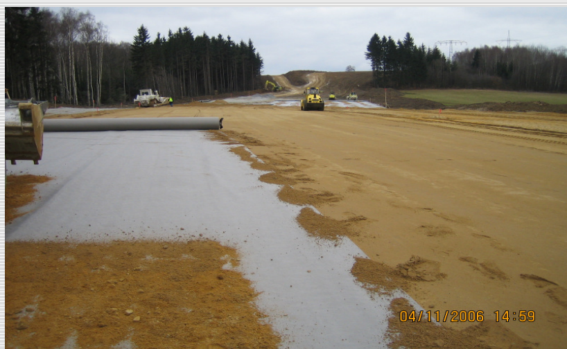
Abb. 2: Verlegung des Vliesstoffes
