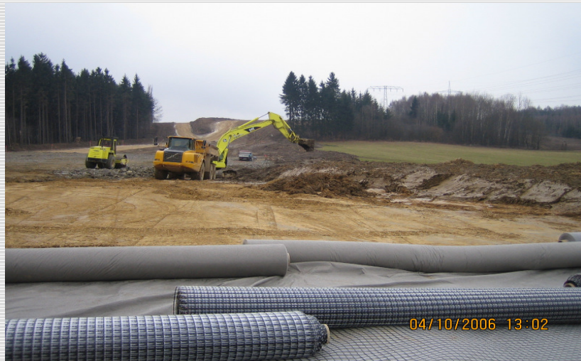
Abb. 1: Vorbereiten des Untergrundes
