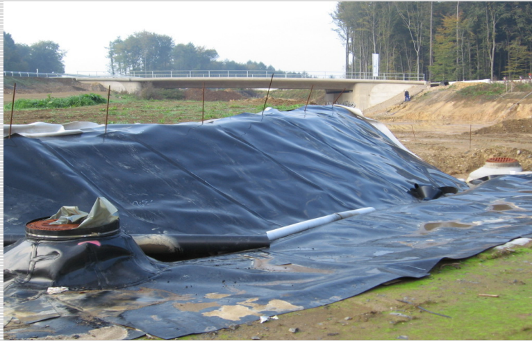
Abb. 1: Verschweißte Bahnen auf Schutzvlies-Unterlage
