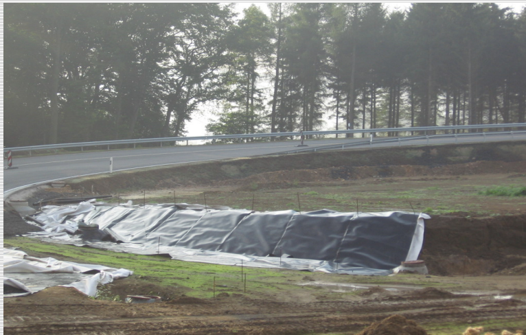
Abb. 2: Auskleidung von Drainagegraben und Böschung
