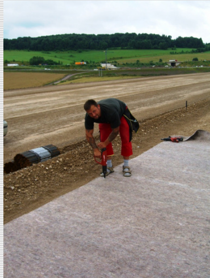
Abb. 4: Befestigung des Vlies
