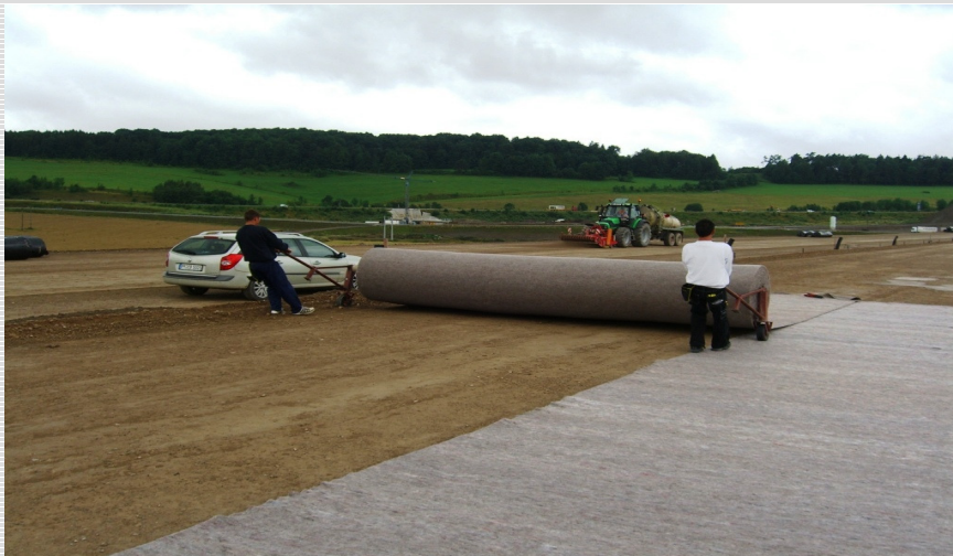
Abb. 2: Ausrollen des Vlies mit Verlegegerät
