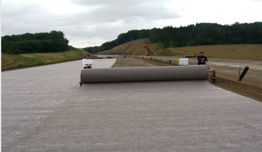
Abb. 3: Ausrollen des Vlies mit Verlegegerät
