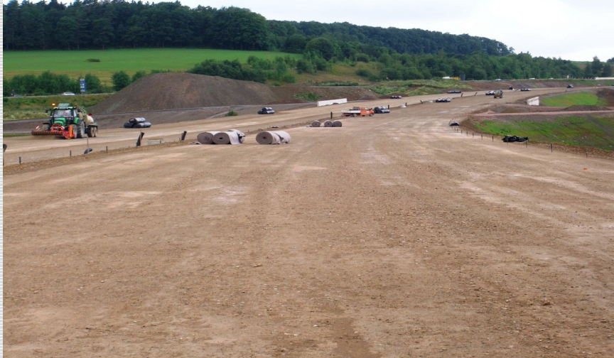
Abb. 1: Baufeld vor der Verlegung mit seitlich gelagerten Vliesrollen
