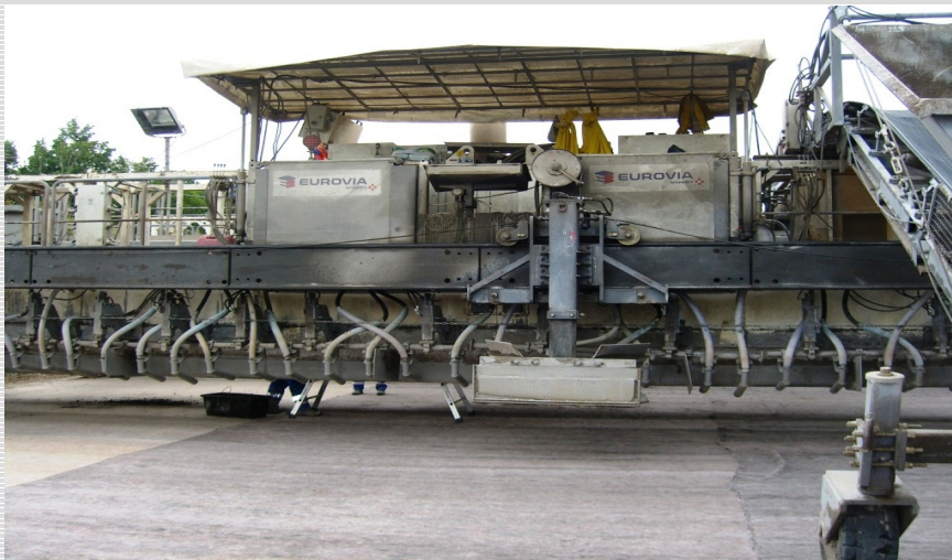
Abb. 6: Ausrichtung des Fertigers
