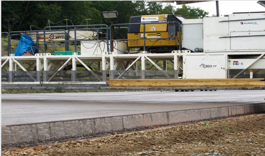
Abb. 7: Fertige Betondecke
