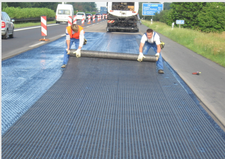
Abb. 2: Verlegung unter Spannung per Hand, auf angesprühter Asphaltfläche
