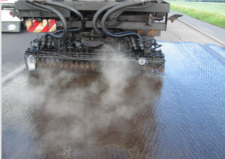
Abb. 1: Anspritzen mit Bitumenemulsion
