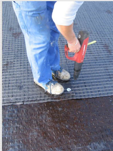
Abb. 4: Anschließen an der Querüberlappung
