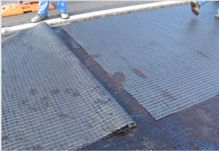
Abb. 3: Detail Längsüberlappung
