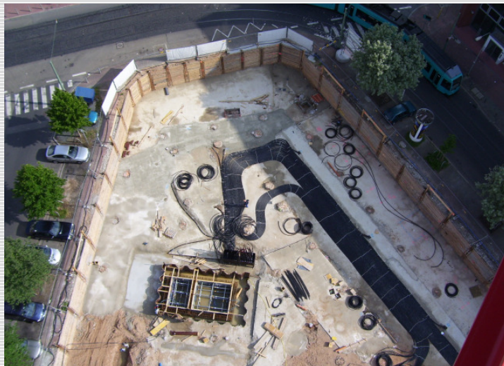
Abb. 2: Blick vom Baukran auf die Anbindeleitungen der Erdwärmesonden
