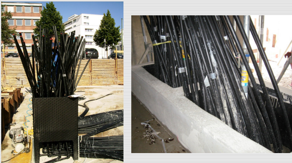
Abb. 3+4: Schalung für die Einführung der Sondenanschlussleitungen
