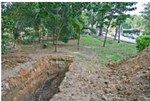
Abbildung 1: Verlegung des SureFIT®-Liners bei ungestörtem Verkehr und minimalen Erdarbeiten.
