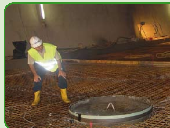
Sohlschacht vor dem Vergießen der WU-Sohlplatte
