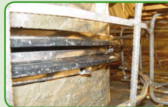
Auf den Sohlschacht aufgezogener Mauerkragen
