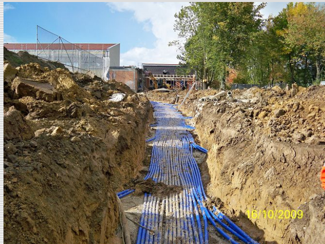
Abb. 2: Anbindeleitungen des Sondenfeldes
