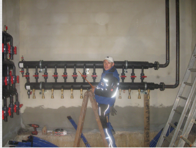
Abb. 5: Montage der Soleverteiler
