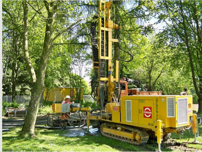
Abb. 2: Erdwärmesondenbohrung durch Max Streicher GmbH
