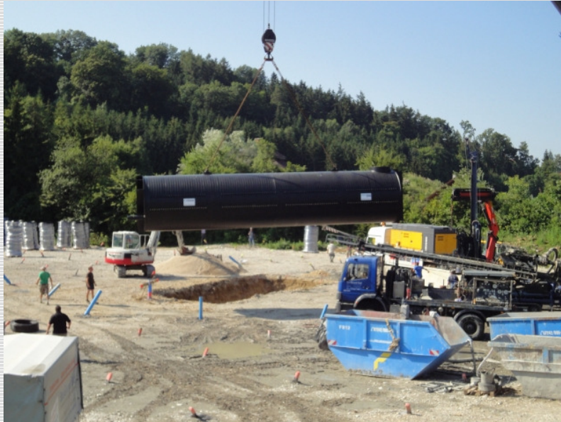
Abb. 4: Versetzen des Schachtes in die Baugrube
