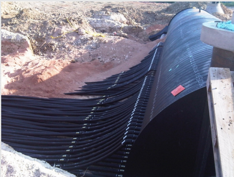
Abb. 6: Bauseitiger Anschluss der Sondenleitungen
